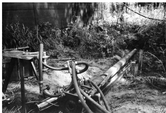
Рис. 3. Забивание стальной трубы в грунт при помощи экспериментального устройства ударного действия внутреннего сгорания с пневмозапуском.
