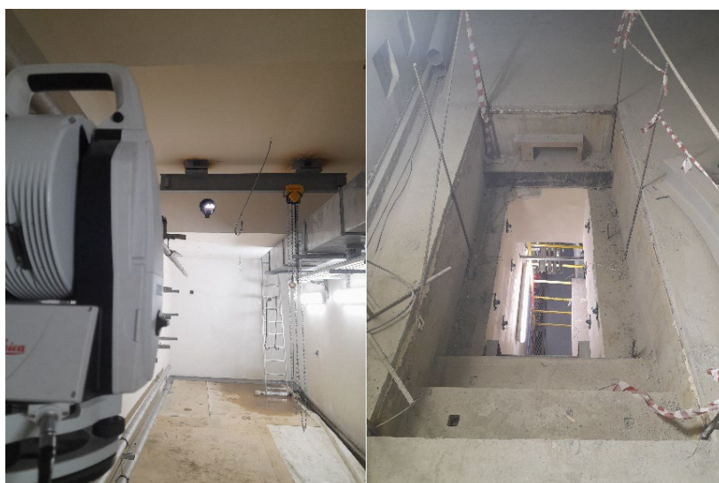
Рис. 7. Съёмка для связи сетей инъекционного комплекса и кольца накопителя
