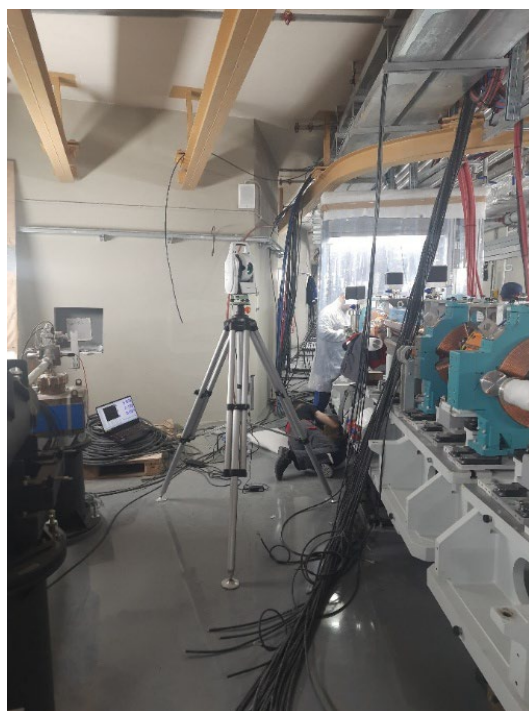
Рис. 10. Монтаж гирдеров с вакуумными камерами
