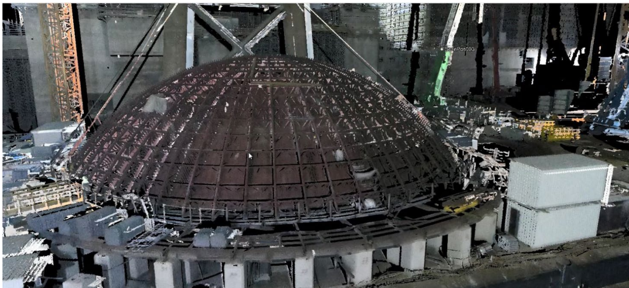
Рис. 5. Сканирование купола на стапеле
