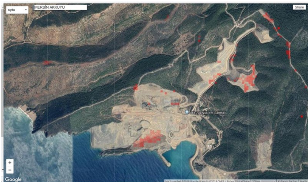
Рис. 1. Промышленная площадка АЭС «Аккую»
