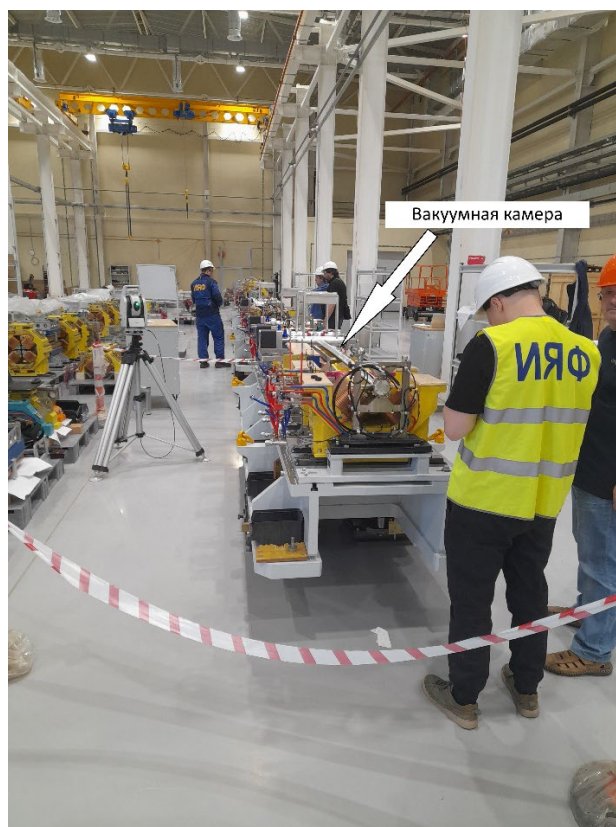
Рис. 4. Гирдер с установленной вакуумной камерой
