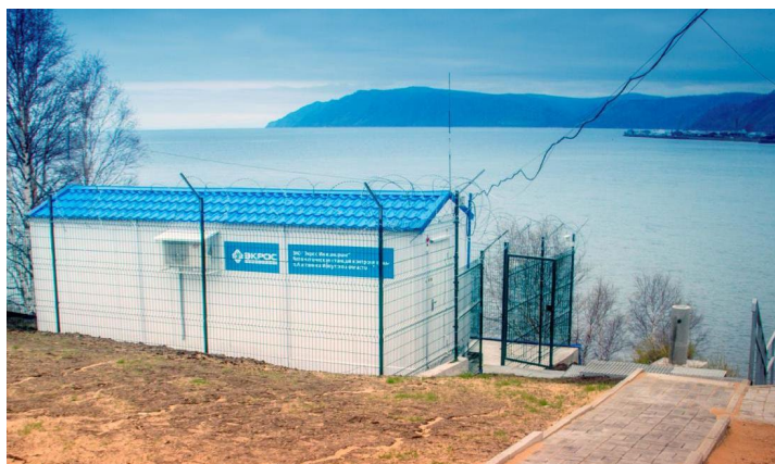
Рис. 3. Автоматизированная станция качества воды
