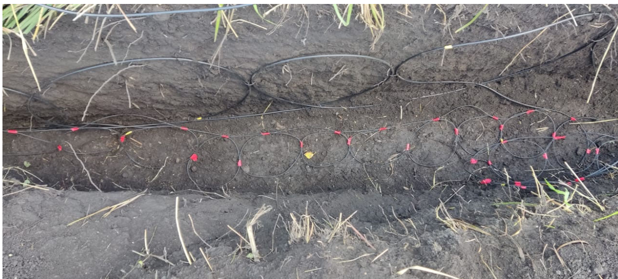
Рис.2. Схема укладки оптоволоконного кабеля в части траншеи. Кольцами на дне уложено оптоволокно, которое было перебито в процессе установки, под ним прямой оптоволоконный кабель.
