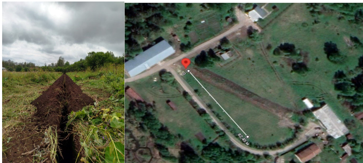
Рис. 1. Траншея для укладки оптоволоконного кабеля –вид до закапывания (слева), глубина около метра, ширина 20-30 см. Обозначение расположения профиля на спутниковом снимке (справа).
