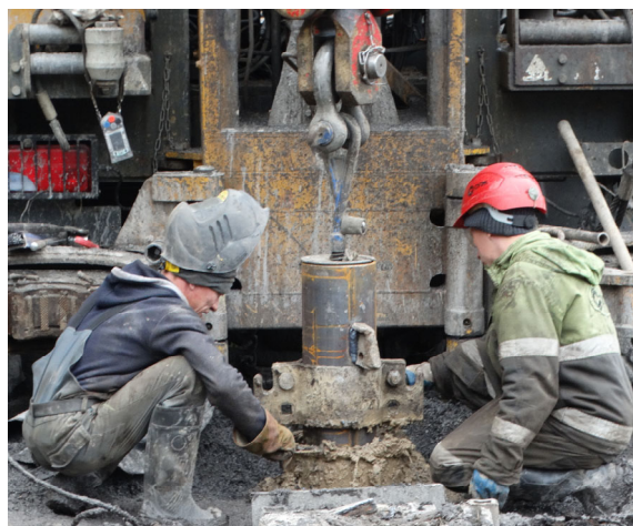
Рис. 1. Герметизация межтрубного пространства перед сварочными работами
