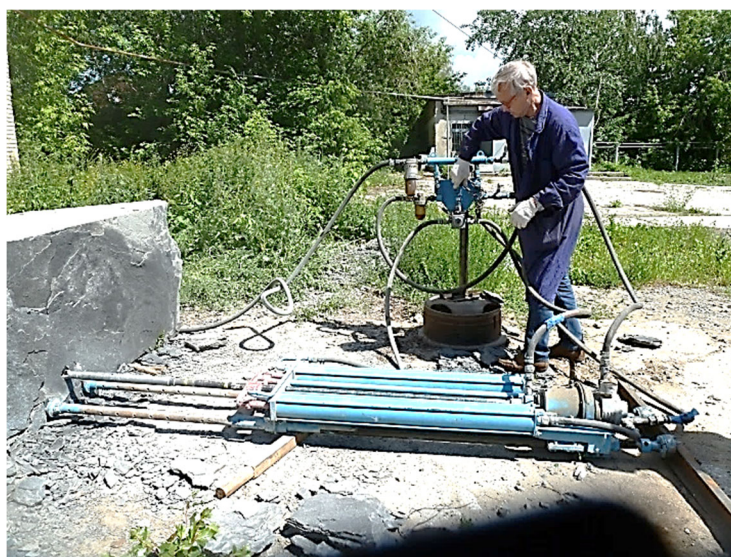
Рис.3. Станок буровой СБП на испытательной площадке
