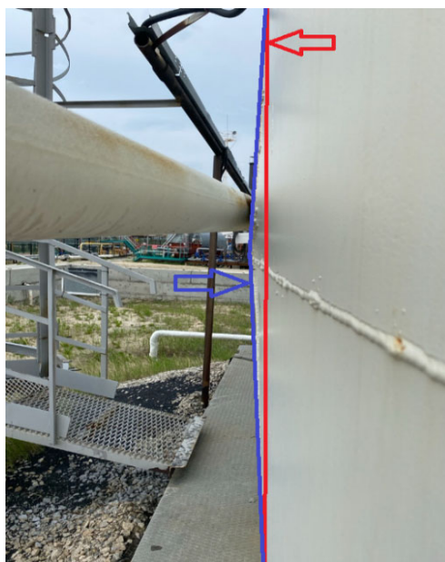
Рис. 8. Выпучивание вертикально-образующей стенки РВС №4
