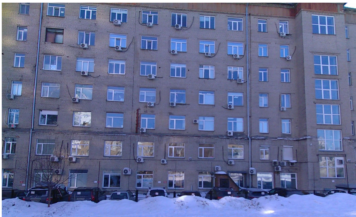
Рис. 2. Фасад с плохой освещенностью
