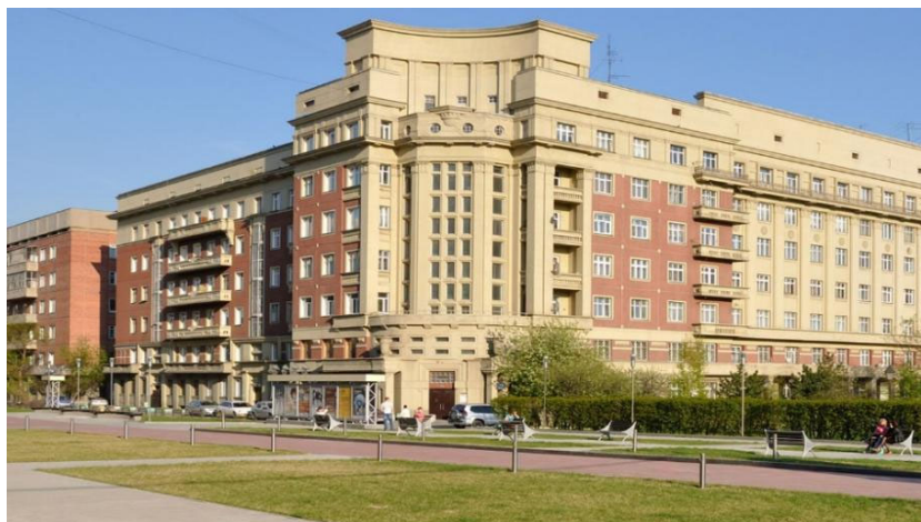
Рис. 1. Стоквартирный дом на площади Свердлова
