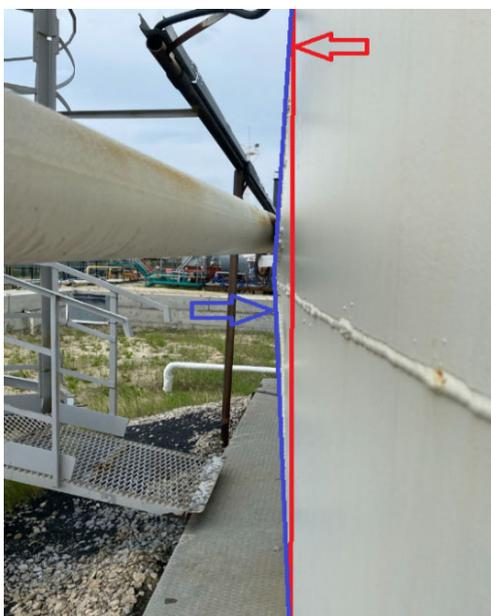
Рис. 8. Выпучивание вертикально-образующей стенки РВС №4
