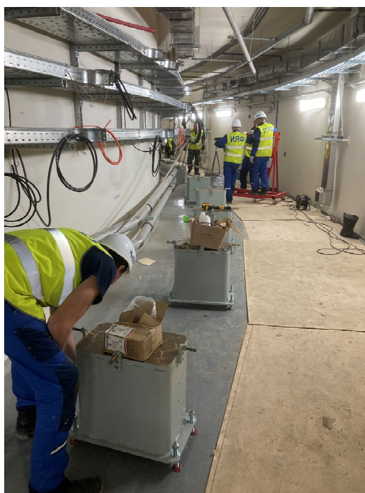
Рис. 5. Процесс установки тумб гирдерных модулей в тоннеле Бустера
