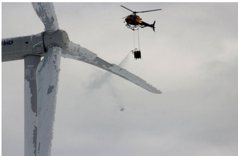
Рис. 1. Процесс борьбы со льдом при задействовании вертолета [2]
