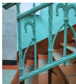
Рис 1. Ограждение лестницы: место утраченного декоративный элемента.
