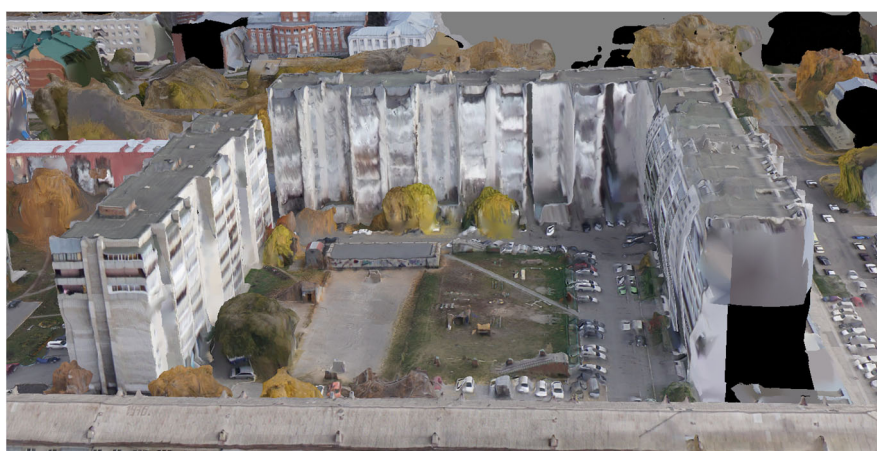
Рис. 5. Трехмерная модель территории, построенная в ходе обработки материалов аэрофотосъемки с маршрутами в направлении Б
