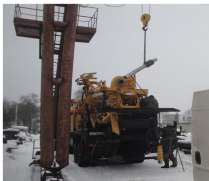
Рис. 3. Замена технологического переходника на установке УБВ-318 в г. Кемерово
