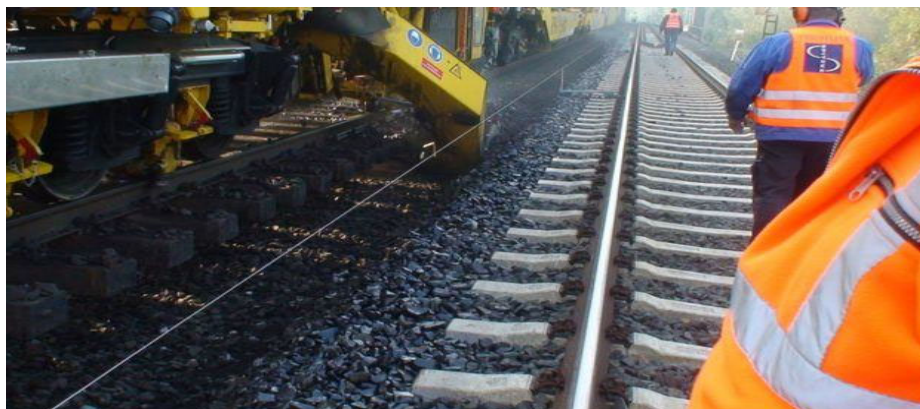
Рис. 3. Применение копировочной струны для постановки железнодорожного пути в проектное положение
