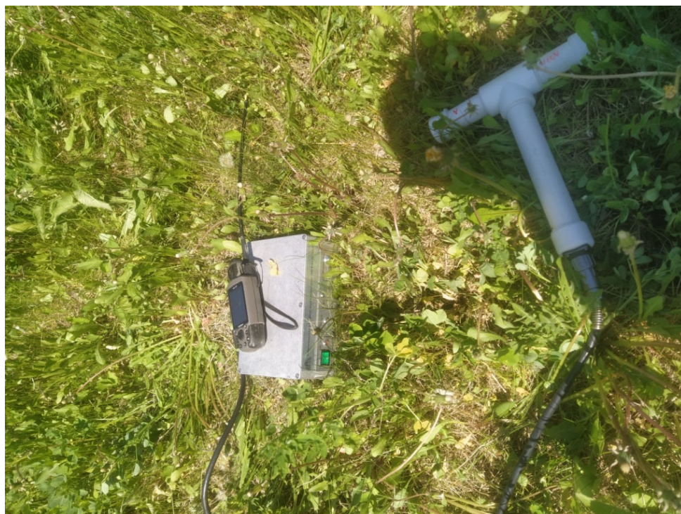
Рис. 1. Измерение параметров ЕИЭМПЗ вблизи трещин закола оползневого склона. На фотографии трещина прослеживается от лицевой панели регистратора до выносного датчика.
