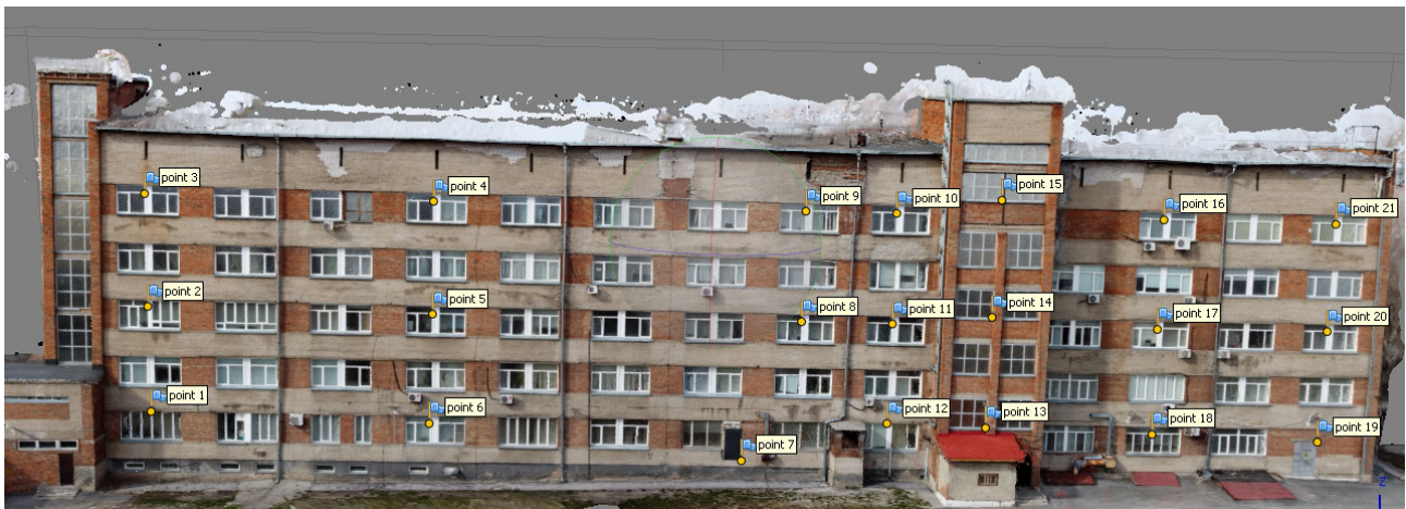
Рис. 4. Расположение опорных и контрольных точек на фасаде
