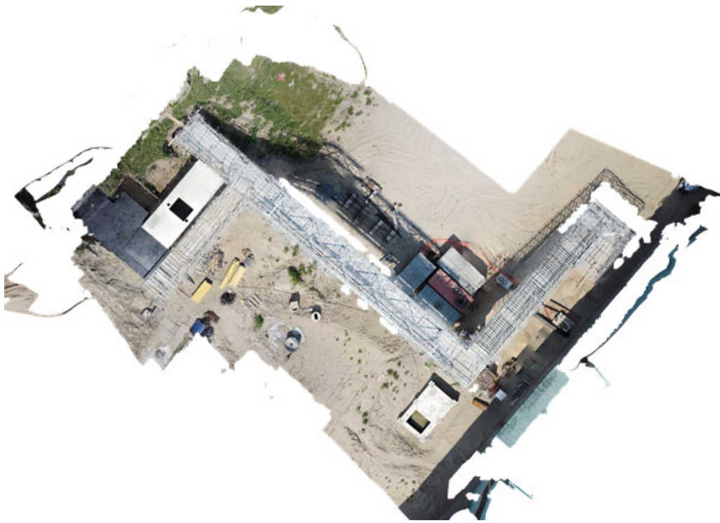
Рис. 3. Ортофотоплан строительной площадки, июль
