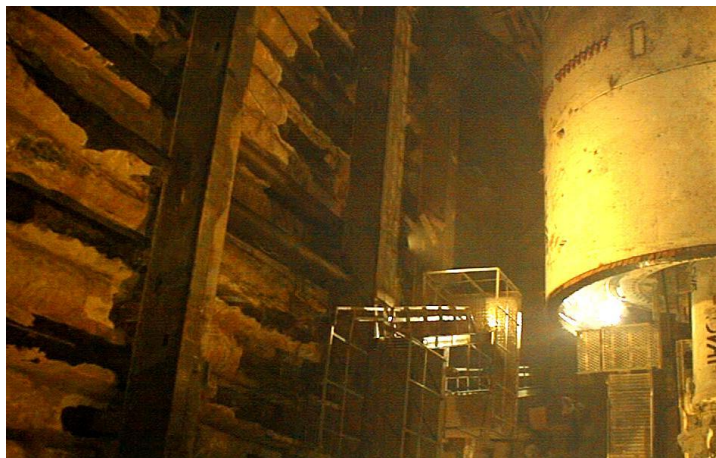
Рис. 2. Вид сверху внутри камеры на проходческий щит (он справа) и подпорную стену из забитых в грунт труб диаметром 377 мм при помощи пневматического молота Тайфун-190.
