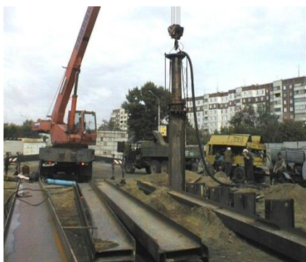
Рис. 3. Сооружение подпорной стены в грунте при строительстве станции метро "Березовая роща" в Новосибирске открытым способом: пневматический молот Тайфун-500 забивает двутавр (слева) и ряд забитых в грунт двутавров
