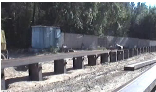
Рис. 3. Сооружение подпорной стены в грунте при строительстве станции метро "Березовая роща" в Новосибирске открытым способом: пневматический молот Тайфун-500 забивает двутавр (слева) и ряд забитых в грунт двутавров
