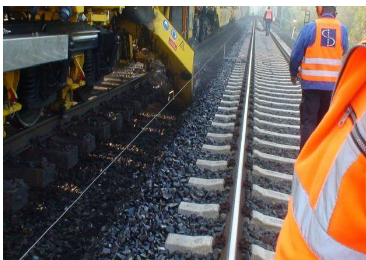
Рис. 4. Применение копир-струны при проведении ремонтных работ
