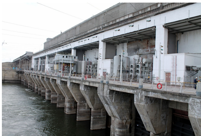
Рис. 1. Общий вид места расположения створа на трансформаторной площадке ГЭС
