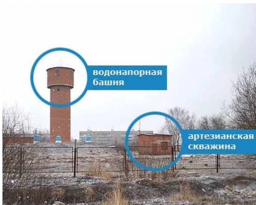
Рис. 4. Первый пояс ЗСО подземного источника водоснабжения
