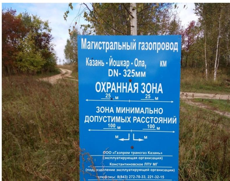
Рис. 3. Пример прохождения подземного магистрального трубопровода
