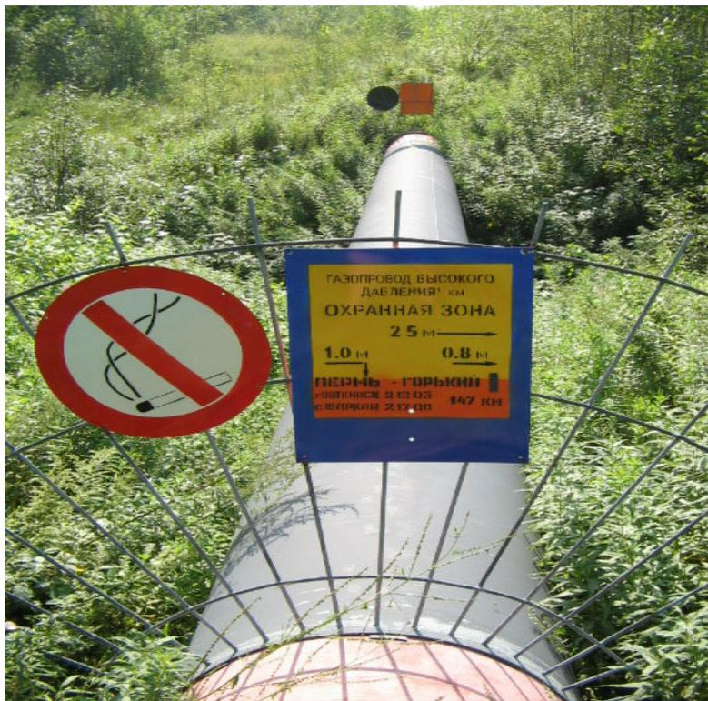
Рис. 2. Наземный магистральный трубопровод
