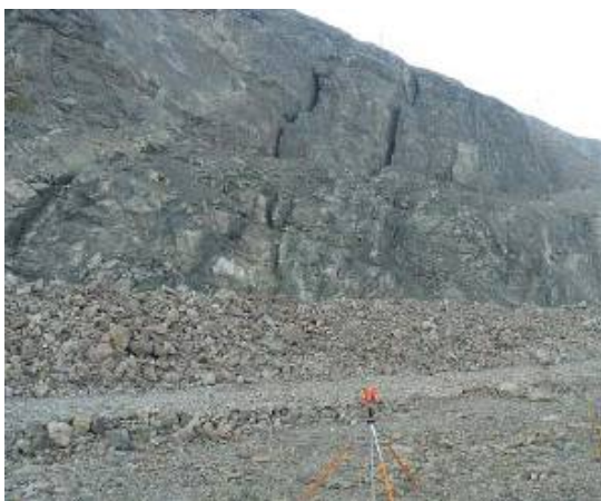
Рис. 5. Деформации западного борта Соколовского карьера
