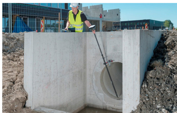
Рис. 2. Применение инерциальной системы для координирования углов здания в местах с частично закрытым небосводом
