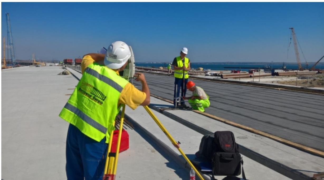
Рис. 5. Контроль высотного положения копирной струны
