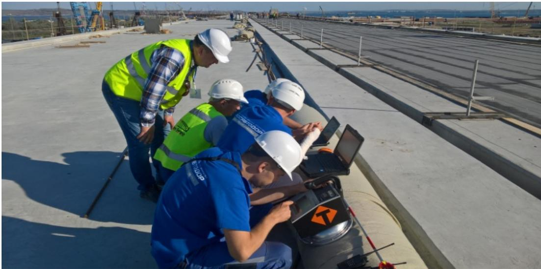
Рис. 4. Камеральная обработка результатов измерений ровности копирной струны
