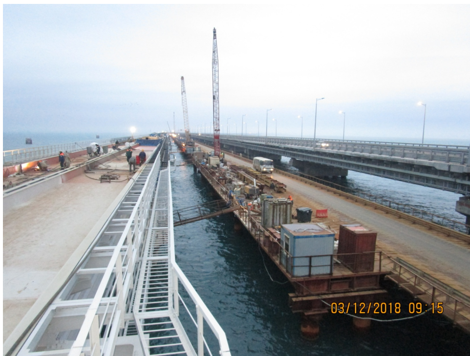
Рис. 1. Железнодорожный мостовой переход через Керченский пролив
