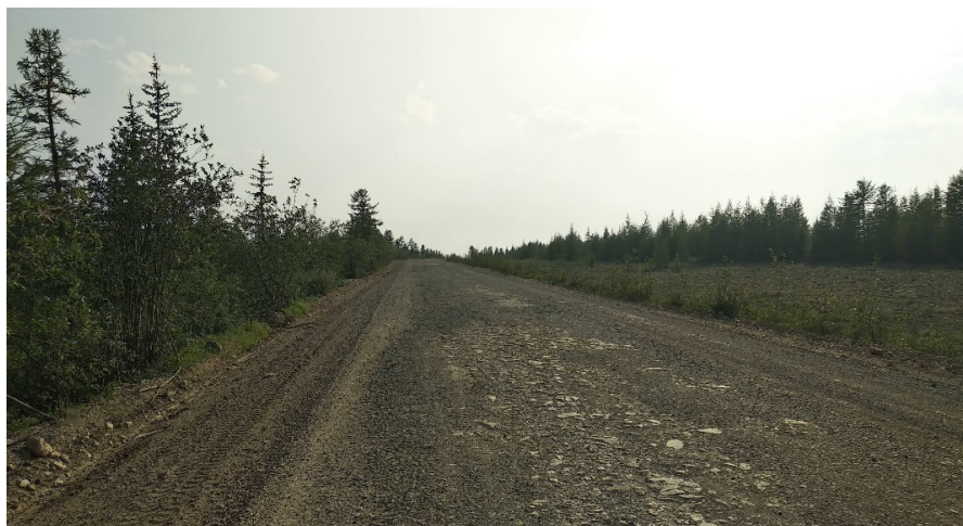
Рис. 2. Вид на автодорогу пос. Айхал – г. Удачный
