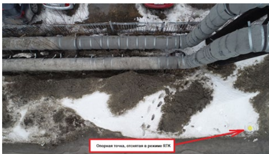
Рис. 2. цифровой фотоснимок наземной инженерной коммуникации с видимой опорной точкой
