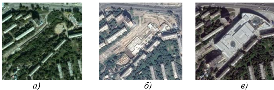
Рис. 1. Этапы строительства ТРЦ «Европейский»:
