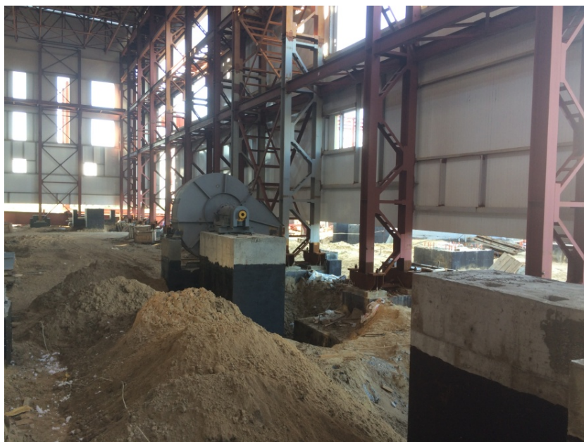
Рис. 1. Вид внутри главного корпуса на момент строительства
