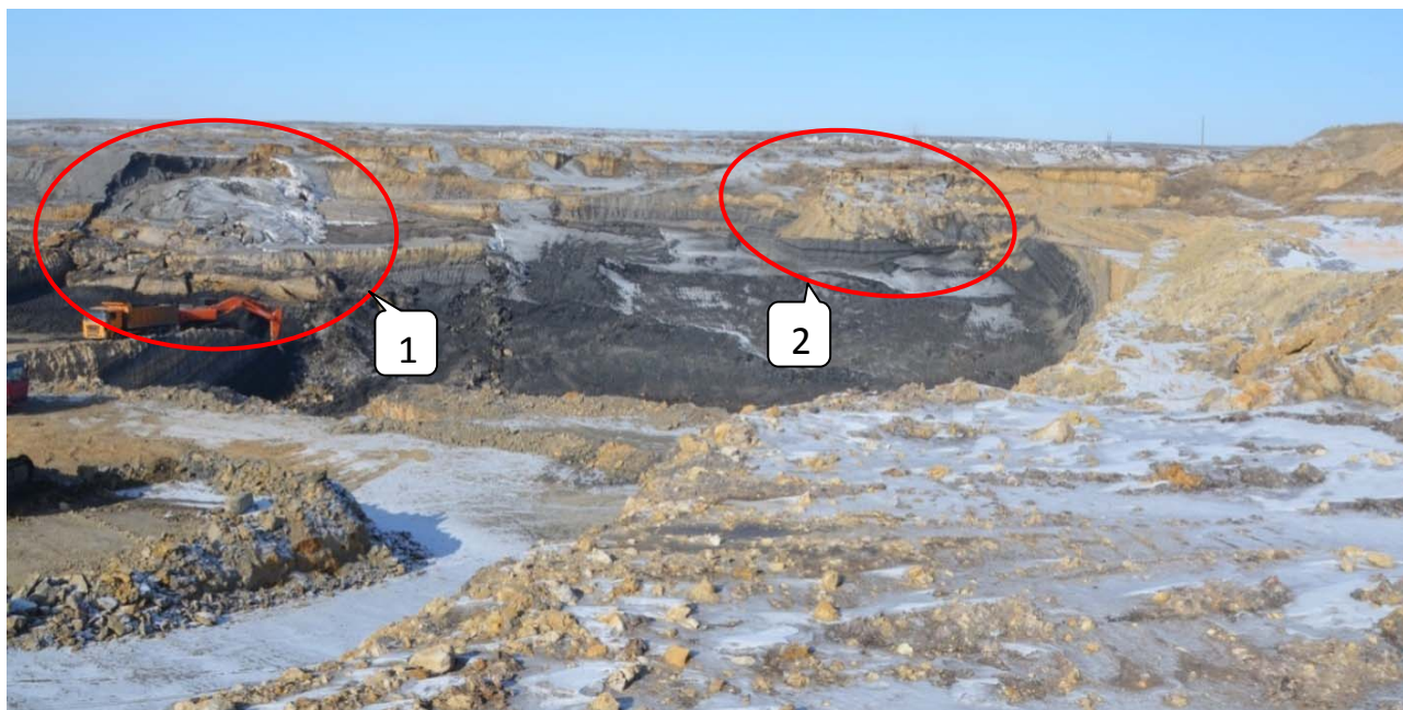
Рис. 2. Деформации на северном борту разреза «Каракомир»
