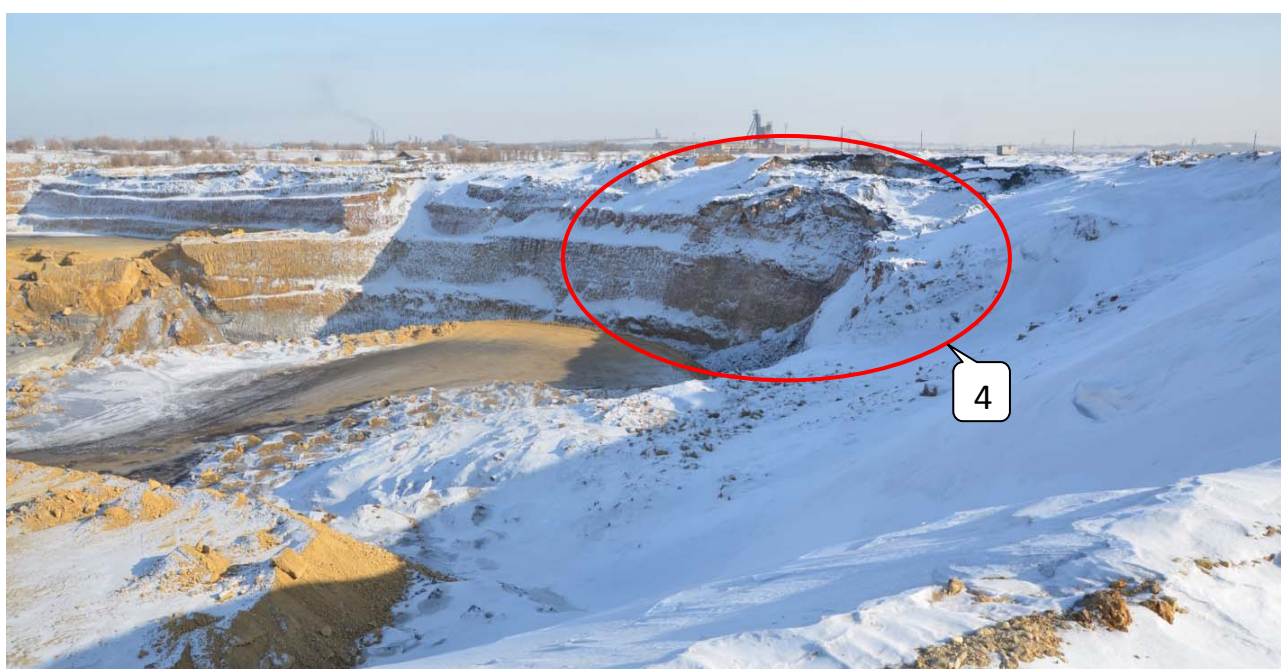
Рис. 4. Деформации южного борта разреза (гор.+551/+534 м)
