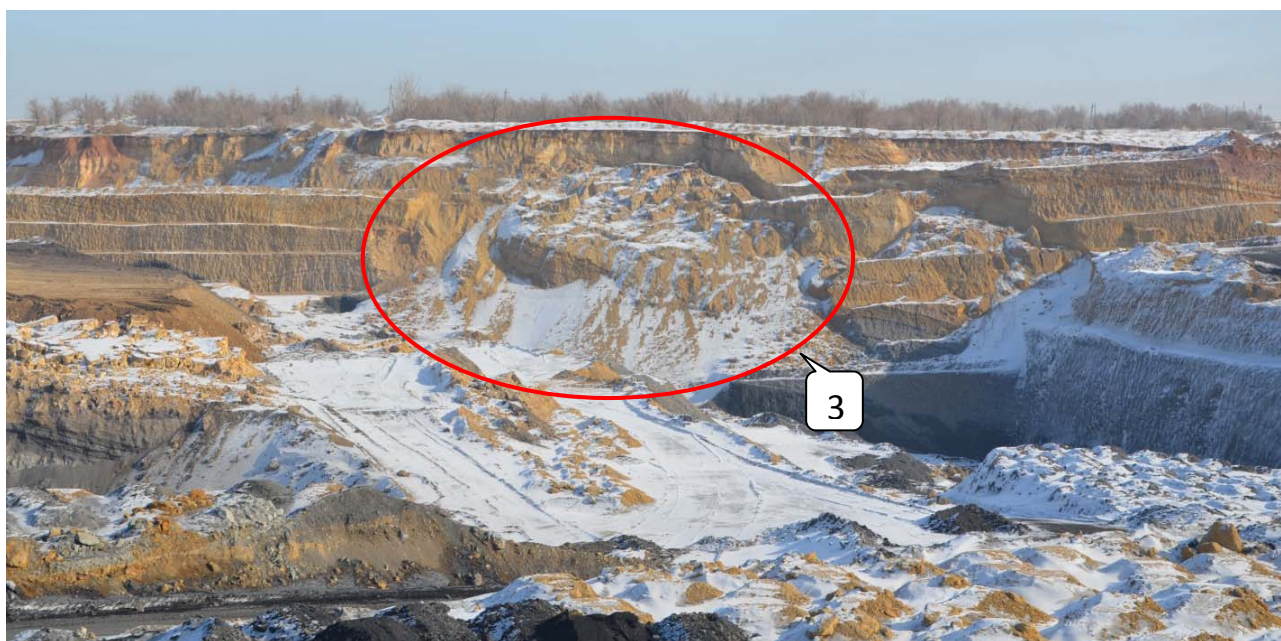
Рис. 3. Деформации восточного борта разреза (гор.+555/+506 м)
