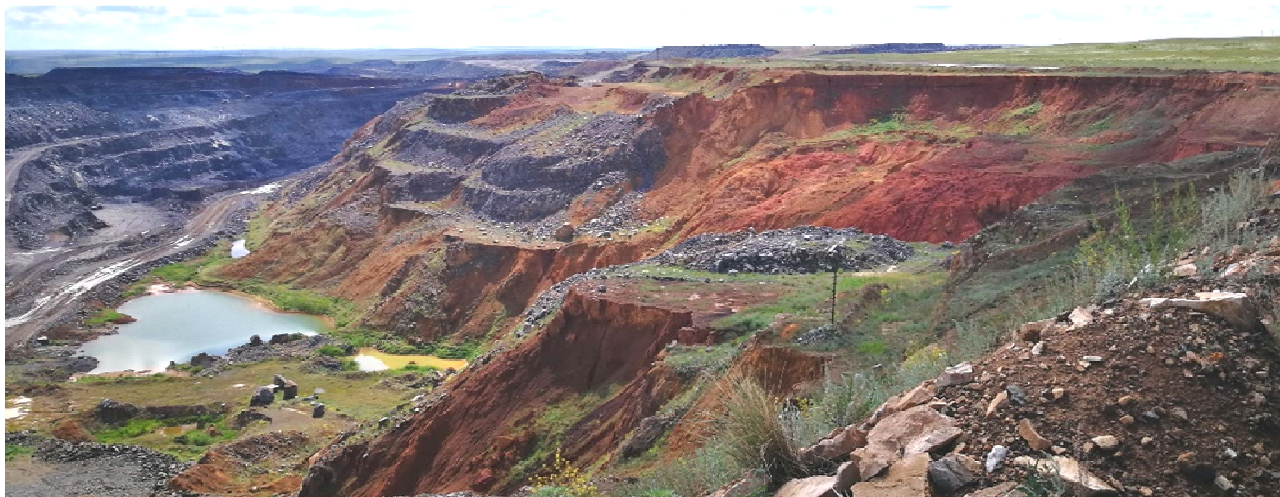
Рис. 3. Оползень уступов, сложенных глинистыми породами на юго-западном борту карьера
