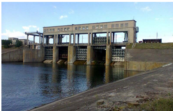
Рис. 1. Плотина Шерубай-Нуринаского водохранилища
