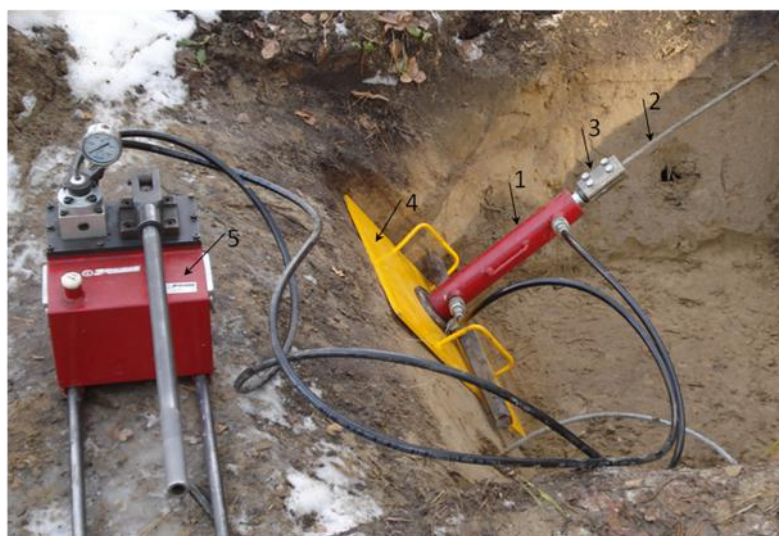
Рис. 2. Анкер в процессе натяжения:
