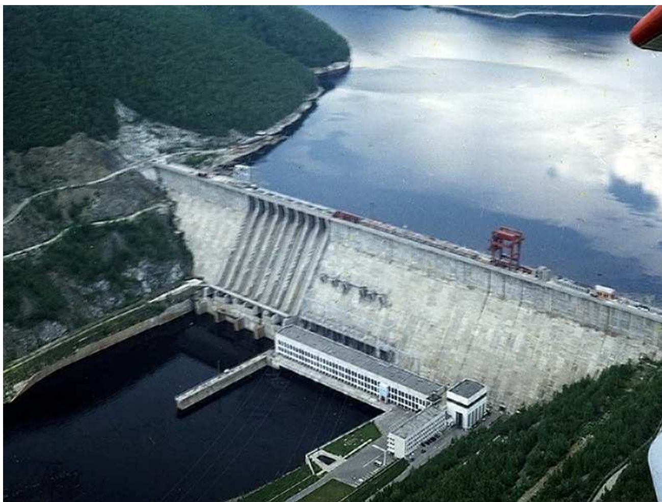
Рис. 4 комплекс сооружений Рогунской ГЭС
