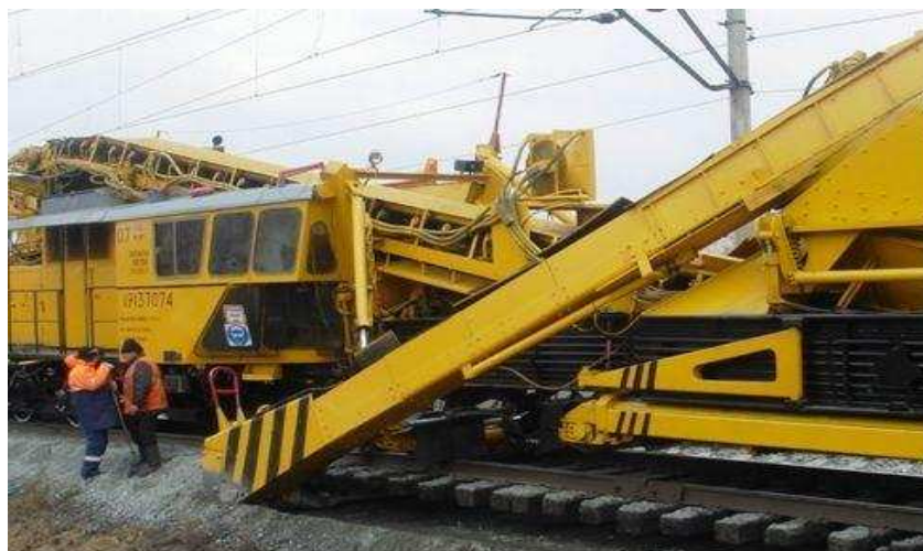
Рис. 2. Вырезка загрязненного балласта щебнеочистительной машиной
