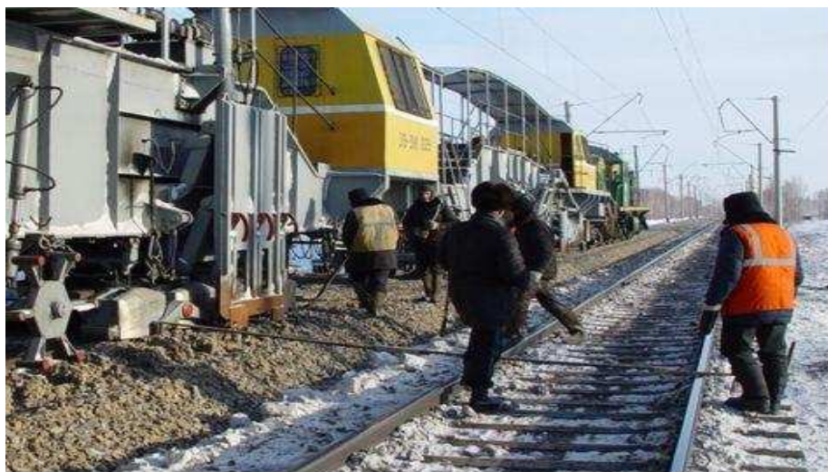
Рис. 3. постановка пути в проектное положение электробалластером (ЭЛБ)
