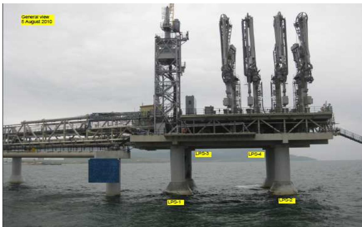
Рис. 2. Опоры загрузочной платформы
