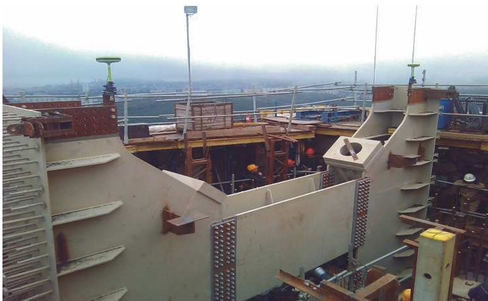
Рис. 3. Процесс измерений спутниковыми приемниками на опоре
