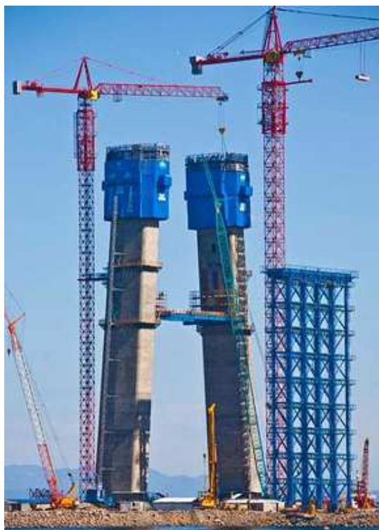
Рис. 1. Сооружение пилонов с помощью самоподъемной опалубки
