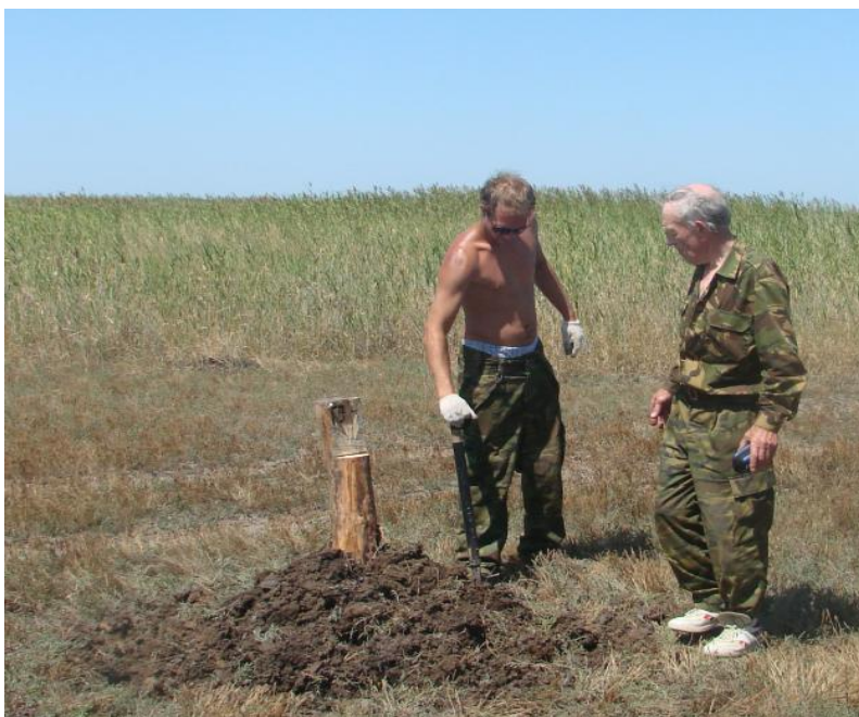
Рис. 2. Установка межевых знаков
