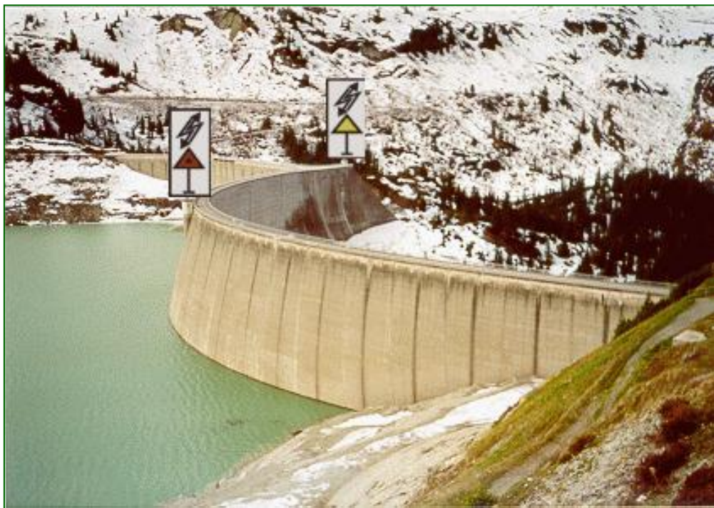
Рис. 7. Инсталляция системы GOCA: расположение пунктов объекта x_O(t) на дамбе Копс, Австрия
