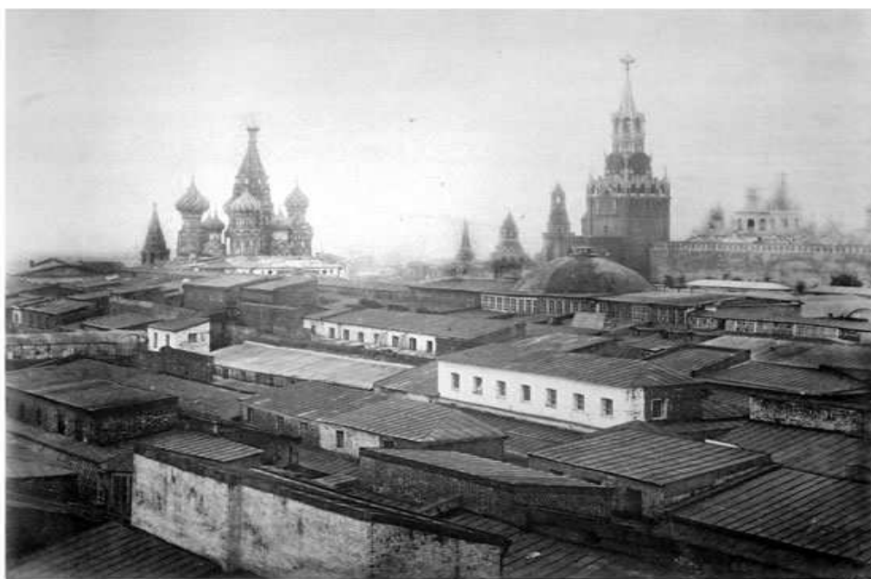
ВЕРХНИЕ РЯДЫ ПЕРЕДЪ ИХЪ ЗАКРЫТИЕМЪ ВЪ 1886 Г. ВИДЪ КРЫШЪ.
