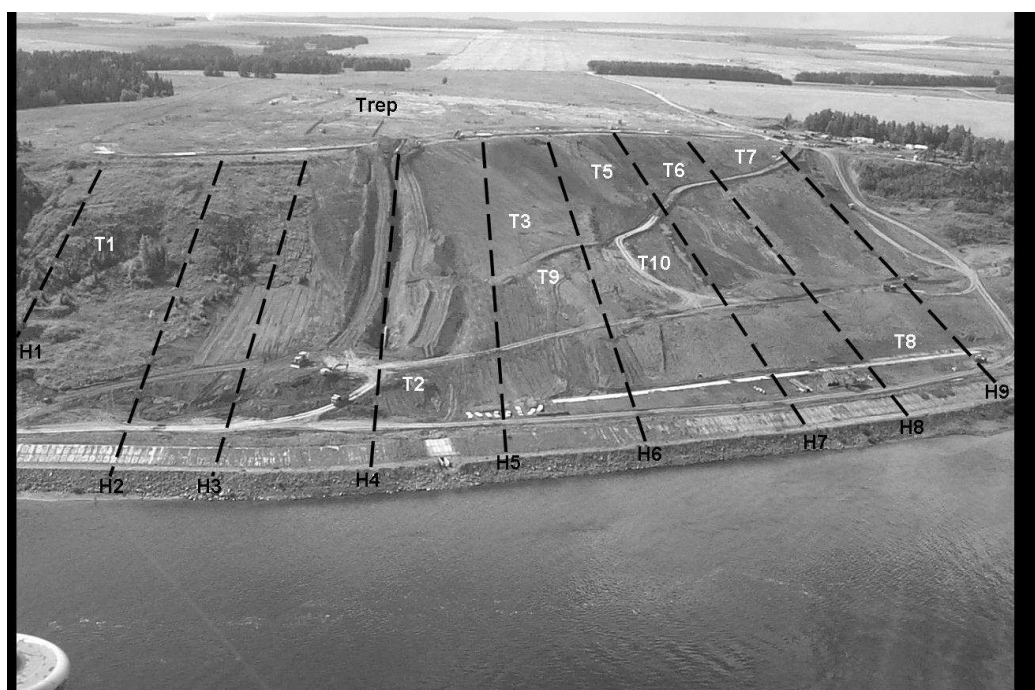
Рис. 1. Вид местности на переходе магистрального газопровода через р. Кама и размещение десяти (Т1-Т10) антивандальных бункеров с регистраторами «МГР-01»
