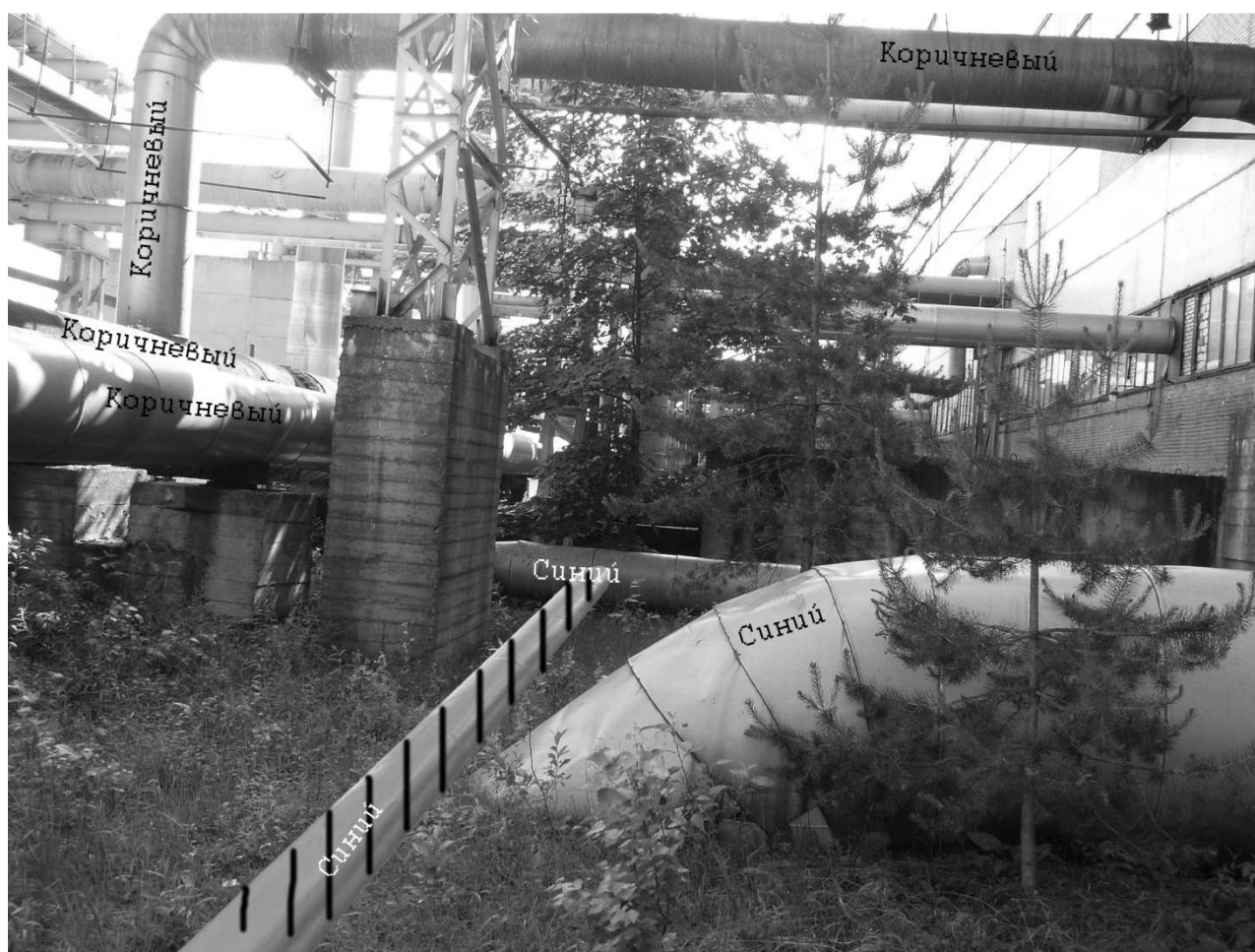
Рис. 3. Фотоснимок с нанесенным проектируемым теплопроводом
