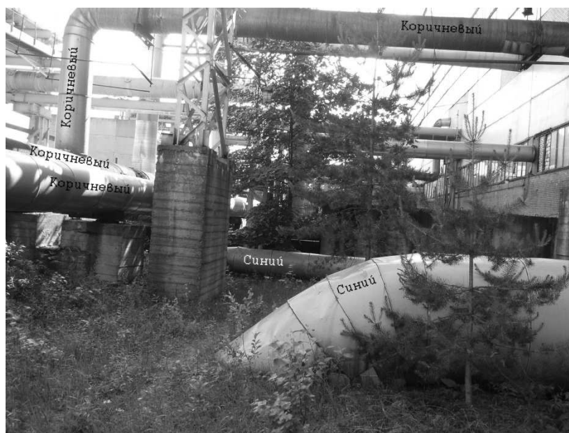
Рис. 1. Фотоснимок участка, где необходимо выполнить проектирования теплопровода
