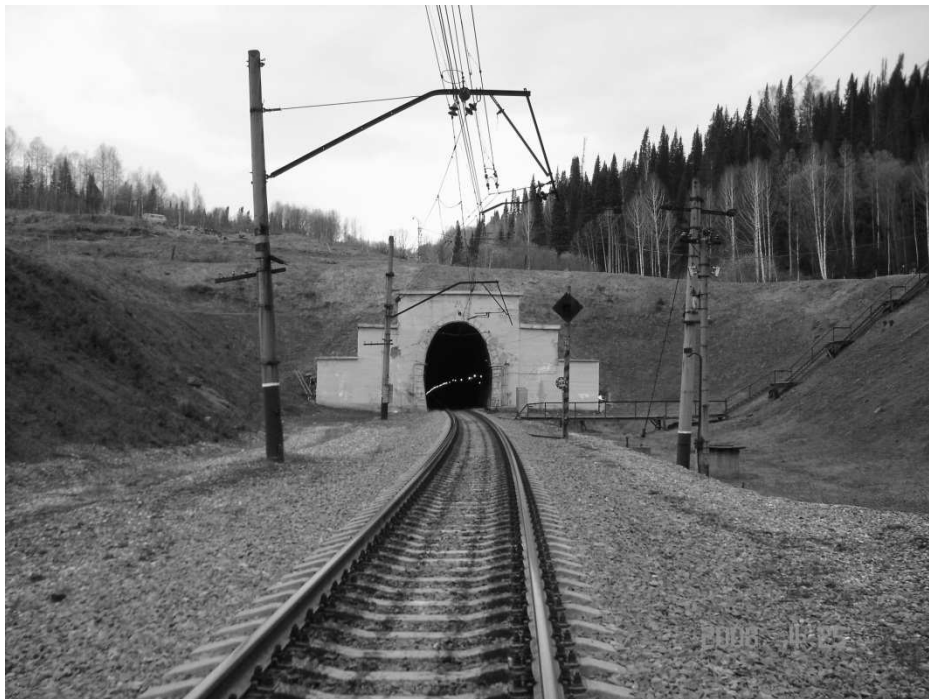
Рис. 1. Восточный портал тоннеля
