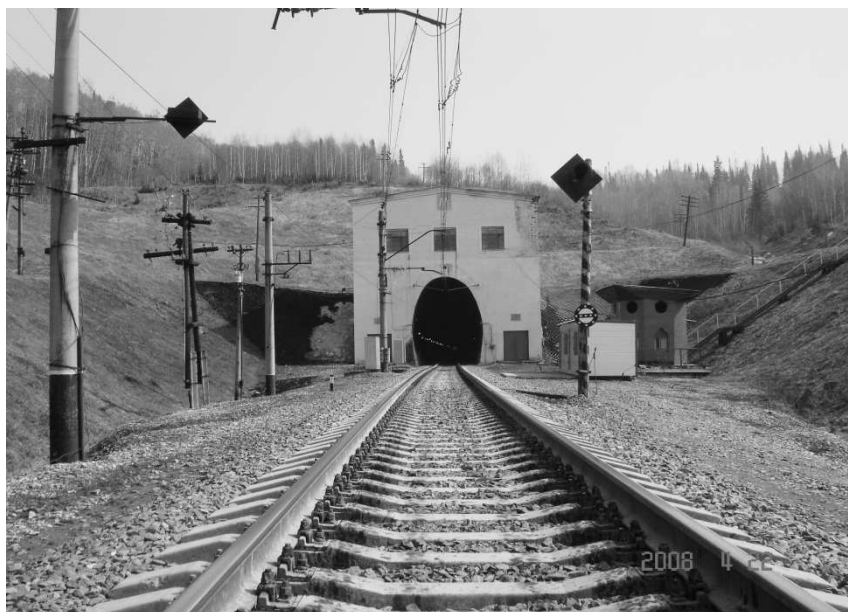
Рис. 1. Вход в тоннель
