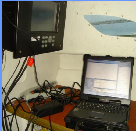
Оборудование установленное в каюте
