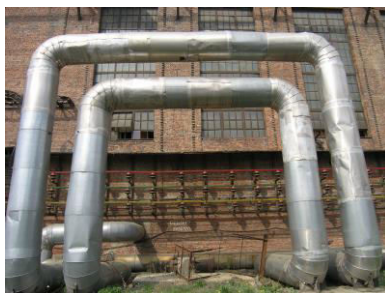
Рис. 3. Тепловой компенсатор
